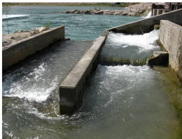
Fish ladder sill 4 th , Var, France ©Philippe Belleudy - Université Joseph Fourier Grenoble
